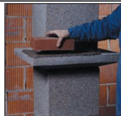
51. При облицовке кирпичом верхней части дымохода над крышей используется консольная плита, на которую затем устанавливаются последующие блоки. Консольная плита монтируется под крышей и выдерживает нагрузку от 4м кирпичной кладки. 2/3 этой конструкции находятся над крышей и 1/3 - под крышей.
