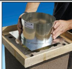
50. Кровельную плиту можно отливать по месту в заранее подготовленной опалубке на стройплощадке или непосредственно на дымоходе. Для монтажа используют бетон марки М300. Перед отливкой плиты необходимо установить манжету и закрыть сечение дымохода от попадания бетонного раствора.
