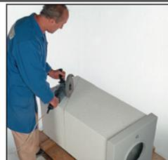
43. Перенесите все размеры на поверхность готового элемента, а затем угловой шлифовальной машиной отрежьте наружную оболочку URATOR.
