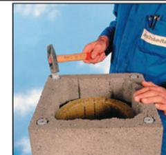
39. При монтаже готовой покровной плиты установите дюбели в отверстия верхней каменной облицовки.
