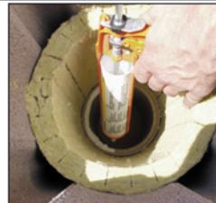
27. Нанесите смесь для заделки швов на нижнюю грань внутренней керамической трубы.
