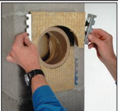
30. Прикрепите к изоляционной панели металлические фиксирующие уголки, а затем установите панель в отверстие.
