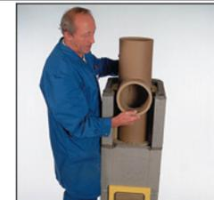
20. Установите внутрь тройник для подключения потребителя. Выступ на верхней грани керамической трубы должен всегда находиться снаружи, канавка внутри. Ориентация т.н. «по воде» действует для всех видов топлива.
