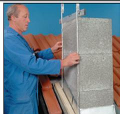
42. При применении готовых решений для оформления верхней части дымовой трубы снимите все необходимые размеры в соответствии с наклоном крыши.
