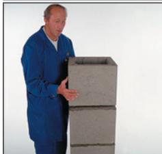
25. Установите каменную облицовку на подготовленный цементный раствор. Монтируйте дымоход индивидуально, не связывайте его с окружающей кладкой. Правило действует как для стен, так и для перегородок.
