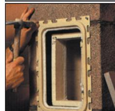
53. Дверцу снять, а раму дверцы выровнять относительно керамической рамки и прибить к блокам.
