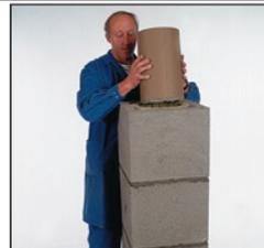
28. Установите внутрь и выровняйте керамическую трубу, удалите избыток массы для заделки швов и заглайте шов губкой. Повторите все монтажные операции в последовательности, изложенной на рис. 25-28, до устья дымовой трубы.
