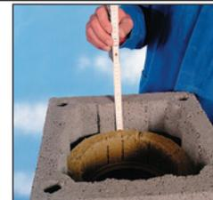
38. Изоляционный материал, устанавливаемый в верхнем блоке дымохода, необходимо обрезать так, чтобы изоляция заканчивалась на расстоянии 6 - 8 см от верхней грани блока!!!
