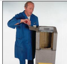
раствор, излишки раствора удалите. Изоляционные панели прорезаями внутрь вставьте в каменный блок. При помощи пилки отрежьте излишки изоляционного материала вдоль каналов проветривания дымохода. На верхнюю грань каменной облицовки нанесите необходимое количество раствора, используя монтажный шаблон.
