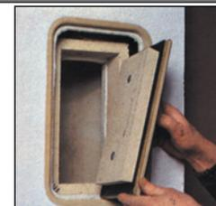
55. Внутреннюю часть дверцы окончательно устанавливаем после затвердевания штукатурки.
