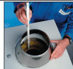
46. Установите конус и измерьте требуемую высоту последнего элемента внутренней керамической трубы.
