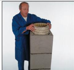
26. Изоляционные плиты согните, вставьте внутрь каменной облицовки и вместе опустите вниз. Изоляционные панели устанавливайте всегда до монтажа внутренних керамических элементов.
