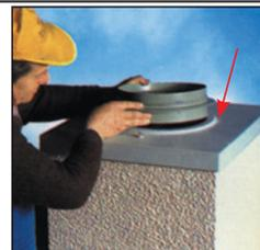
45. На кровельную плиту готового элемента верхней части дымохода установите распорное кольцо. **Перед установкой нанесите на кольцо герметик.**
