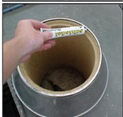
49. Шов между внутренней керамической трубой и конусом уплотните специальным силиконовым герметиком Hermesil.
