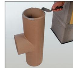
19. Нанесите герметик или массу для заделки швов на нижнюю поверхность керамического тройника для подключения потребителя.
