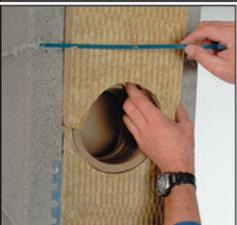
29. Установите переднюю панель из минеральной ваты между керамическим тройником и каменной облицовкой. Уменьшите высоту передней панели при помощи пилки.
