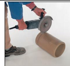
47. Обрежьте внутреннюю керамическую трубу в соответствии с нанесенным размером. На нижнюю грань керамической трубы нанесите требуемое количество массы для заполнения швов и установите внутрь каменной оболочки.
